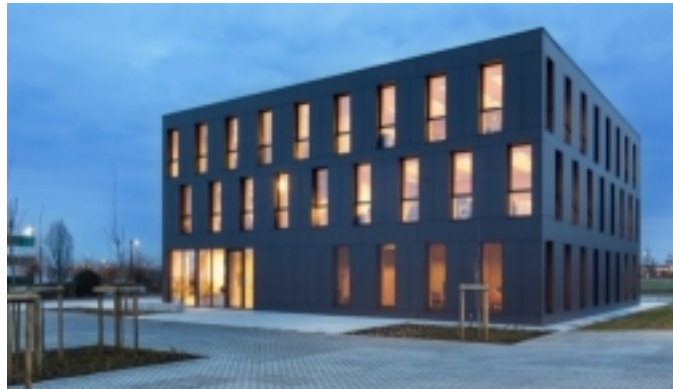
FIGURE 1.1: Bâtiment du CETIC situé dans L'Aéropole de Gosselies
